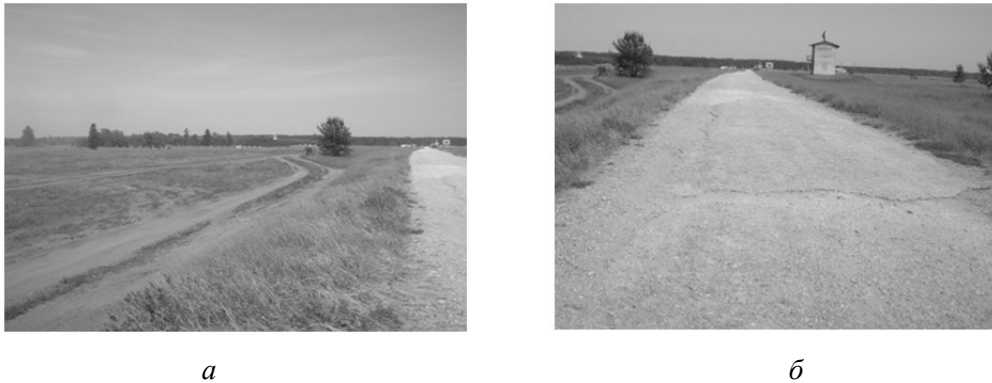
Рис. 5. Ділянки дороги з ґрунтовим (а) та цементно-бетонним (б) покриттям, на яких проводились експериментальні дослідження
